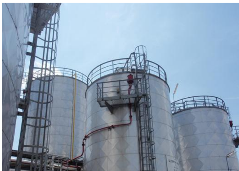
Rys. 1. Zbiornik na biopaliwa w rafinerii Trzebinia
