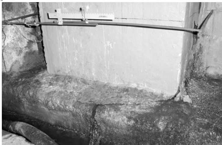
Rys. 9. Fotografia jednej ze szczelin z zamontowanymi systemami (rezystancyjnym i wizualnym)
