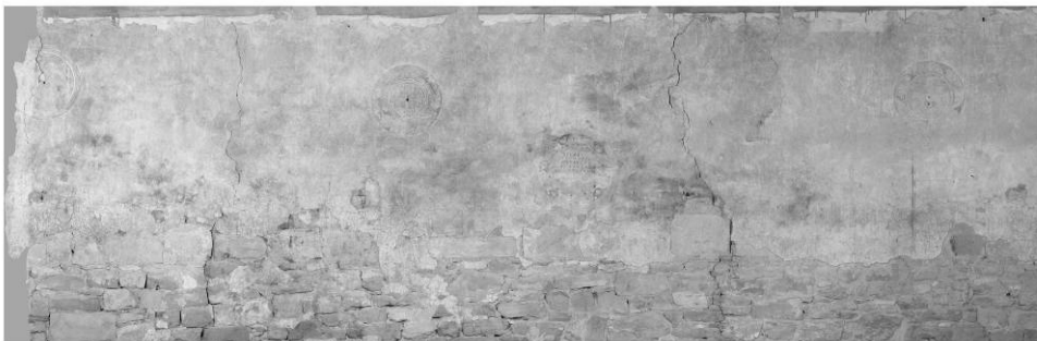
Rys. 7. Ortofotoplan wynikowy - zmontowany z 28 ortoobrazów
