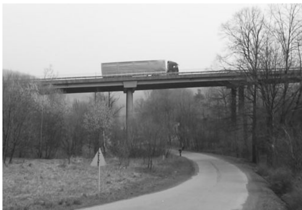
Rys. 22. Widok ogólny badanego wiaduktu
